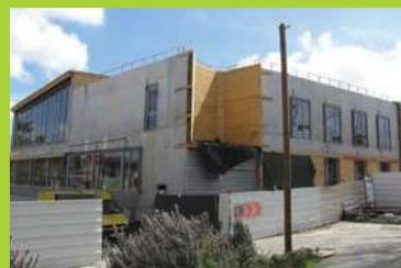
Le gros œuvre, la couverture et les menuiseries extérieures sont finalisés. Les habillages de la façade sont en train d'être posés et l'enduit du patio est achevé. A l'intérieur du bâtiment, la chape support de revêtement de sol est coulée et la verrière surplombant le puits de lumière est en place. Dans les locaux techniques, les radiateurs, les réseaux de plomberie, d'électricité, de chauffage et de ventilation sont installés. La pose des faux-plafonds
