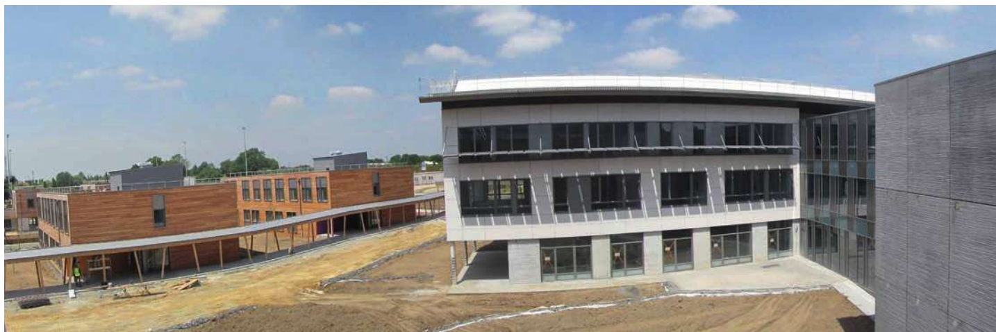
▲ Chantier du lycée, vue de l'intérieur.
