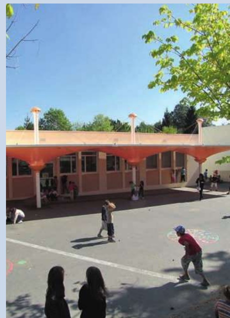
▲ Le nouveau préau du primaire installé à Jacques Prévert en février 2012
