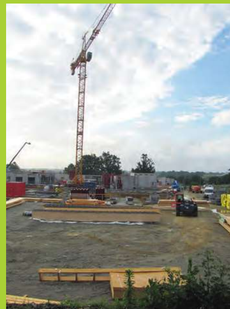
▲ Chantier du nouveau lycée du Sud-Loire
