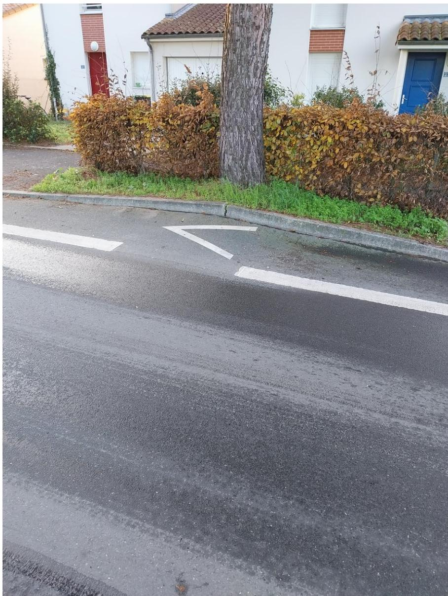
On observe l'impact du système racinaire sur les bordures et les enrobés. Pour l'instant l'impact de celui-ci se cantonne à la piste cyclable mais on a un risque à terme de dégâts sur le reste de la voirie.
