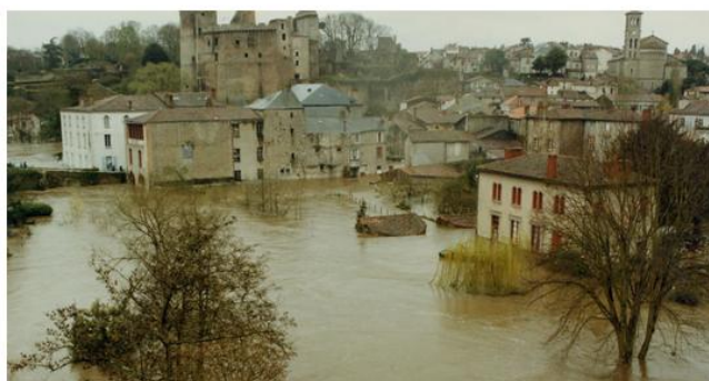
Risque d'inondation à Clisson (source : www.mairie-clisson.fr )
