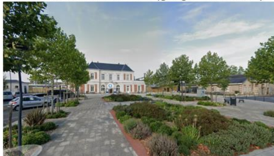
Parvis de la Gare en 2022 (google street view)
