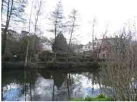
Rive de la Moine, viaduc
