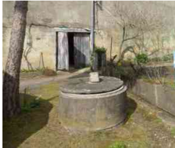
Le Perthuis-Fouques- citerne- ancien puits,
