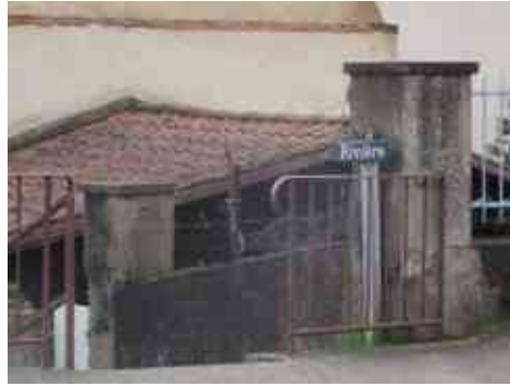
Accès à la Moine depuis le viaduc
