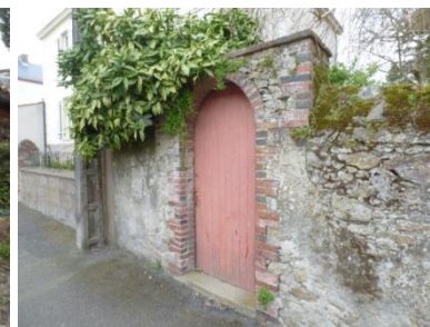
Entrée piétonne et mur de clôture
