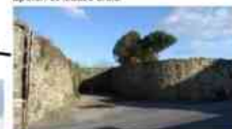
Vestiges de bastion
