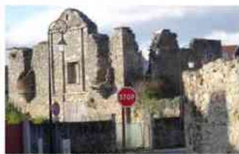
Porte sud de la Ville (MH)
