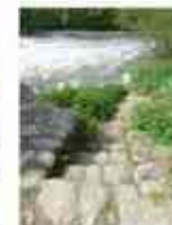
descente vers le canal de fuite
