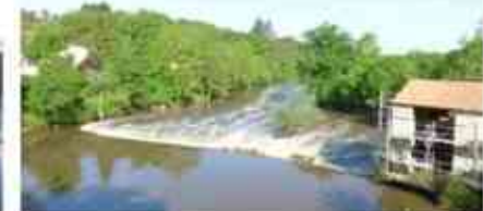
Chaussée du Nid d'Oie
