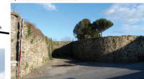
Vestiges de bastion
