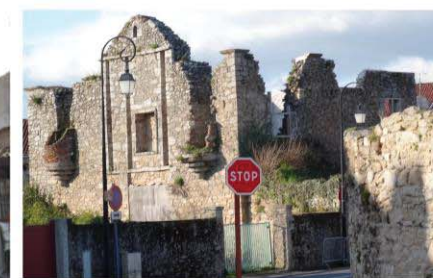
Porte sud de la Ville (MH)
