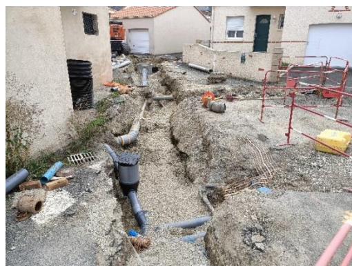
Réhabilitation du réseau EU rue de la société à Saint-Lumine-de-Clisson
