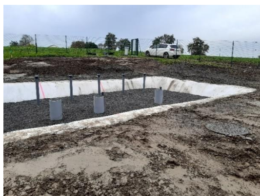
Réhabilitation de la STEP du Plessis Renard
