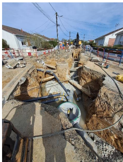
Travaux de mise en séparatif du réseau d'eau usée – Quartier Fief des Pommiers - Clisson
