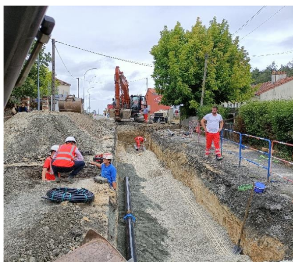
Travaux Fief des pommiers - 2023
