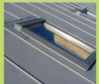
L'intégration du mécanisme se fait dans la continuité des couvertures et la saillie est réduite au minimum.
