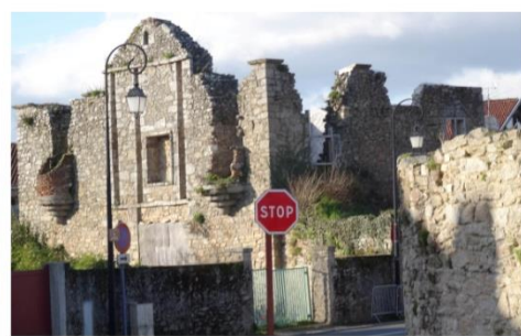
Porte sud de la Ville (MH)
