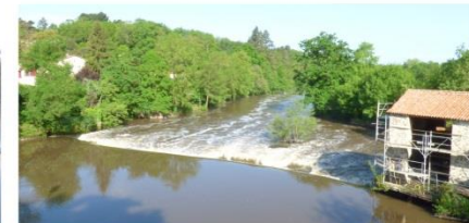
Chaussée du Nid D'oie
