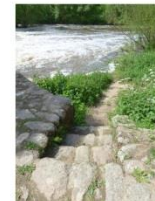
descente vers le canal de fuite
