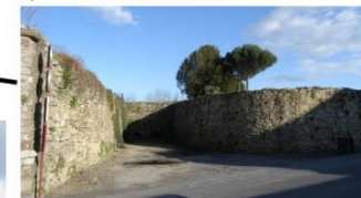
Vestiges de bastion
