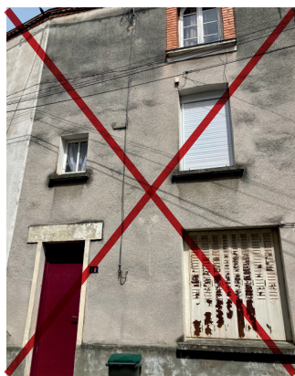
Le manque d'harmonisation des menuiseries ne permet pas de mettre en valeur la façade.
