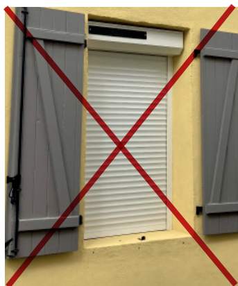
Les volets roulants extérieurs avec coffre apparent sont interdits.
