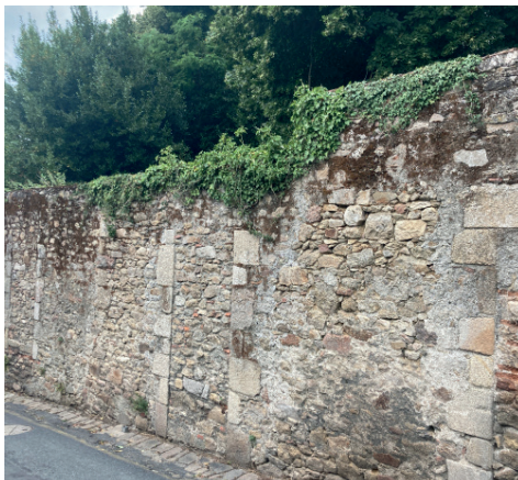
Les murs patrimoniaux de ce type sont protégés.
