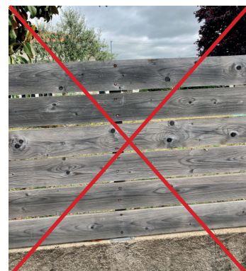
Ces planches ne laissent pas assez d'espace entre elles pour laisser une visibilité depuis la rue.
