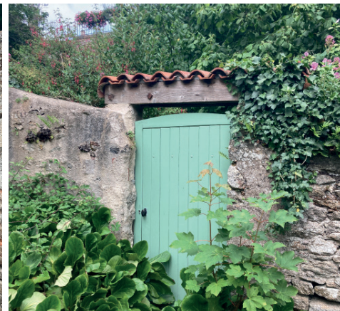
La conservation de la hauteur et l'utilisation de tuiles confèrent un aspect traditionnel réussi à cet accès.
